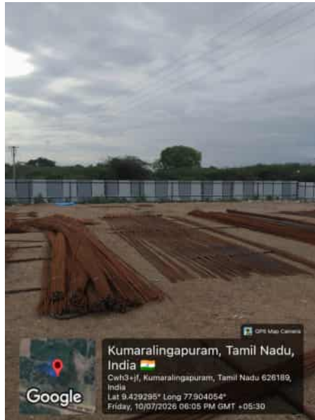
AM-6 D-ELSR-1 Steel Cutting work
