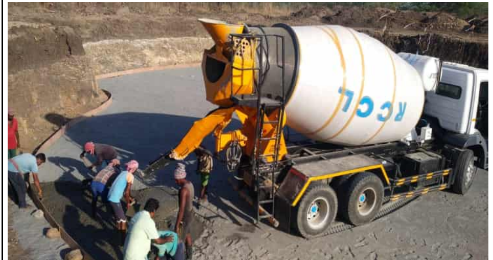
AM-6 D-ELSR-1 PCC Pouring work
