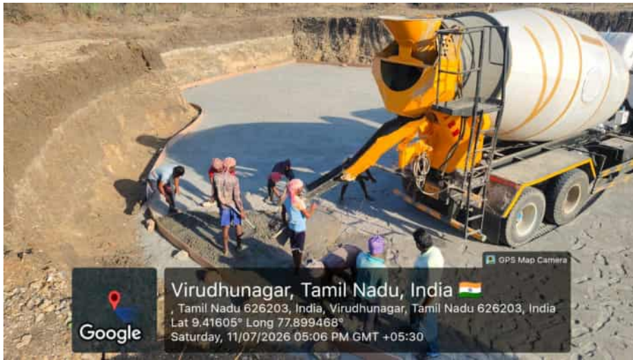
AM-6 D-ELSR-1 PCC Pouring work
