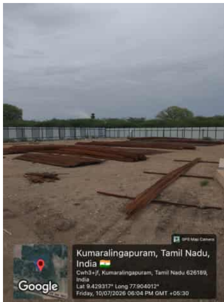
AM-6 D-ELSR-1 Steel Cutting work
