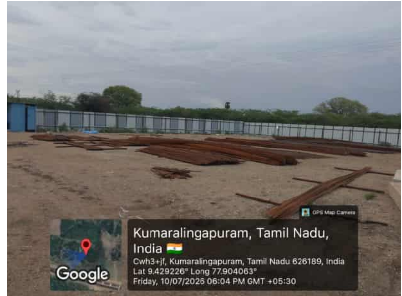
AM-6 D-ELSR-1 Steel Cutting work
