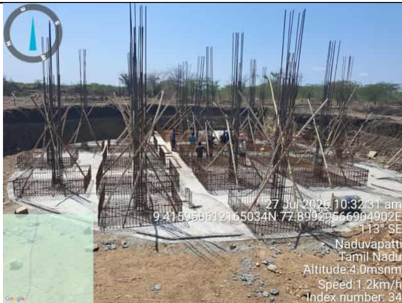
AM-6 D-ELSR-1 Footing Tying work
