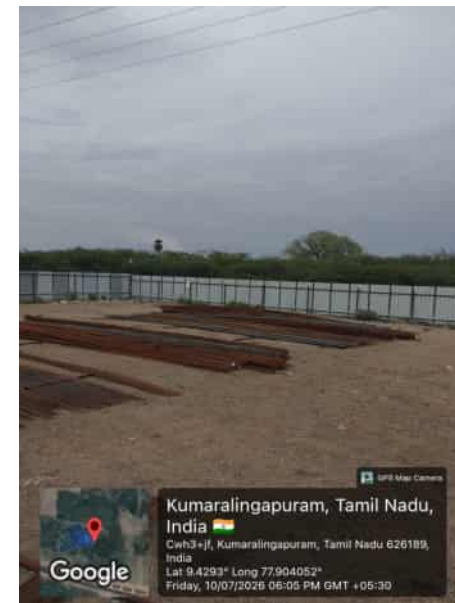
AM-6 D-ELSR-1 Steel Cutting work
